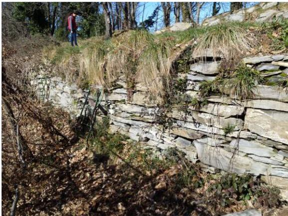
Foto 23. Sentiero M.te Anchetta - M.te Castello: idem, muro di contenimento del terrazzo
